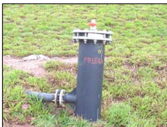
Figura 8- Dreno vertical adaptado com cabeçote em PEAD
