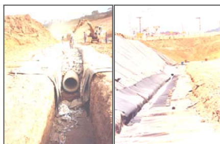
Figura 2- Detalhe drenagem de chorume do aterro
