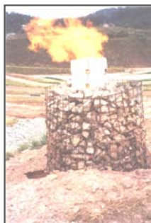
Figura 3- Detalhe dreno vertical do aterro
