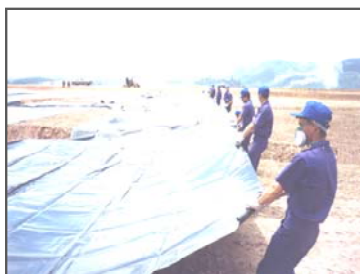
Figura 1- Detalhe de impermeabilização do aterro
