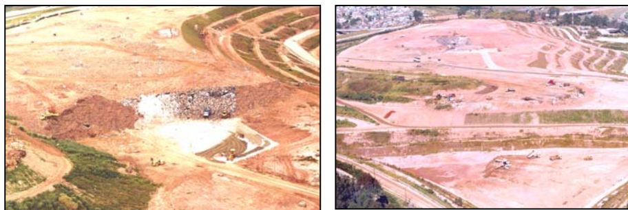
Figura 4- Detalhes de frentes de disposição: a) Frente restrita para resíduos domiciliares b) Diferentes frentes para resíduos diferenciados
